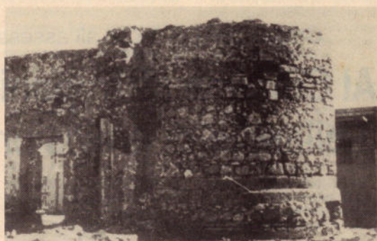
La Torre di Xitta incredibilmente demolita
